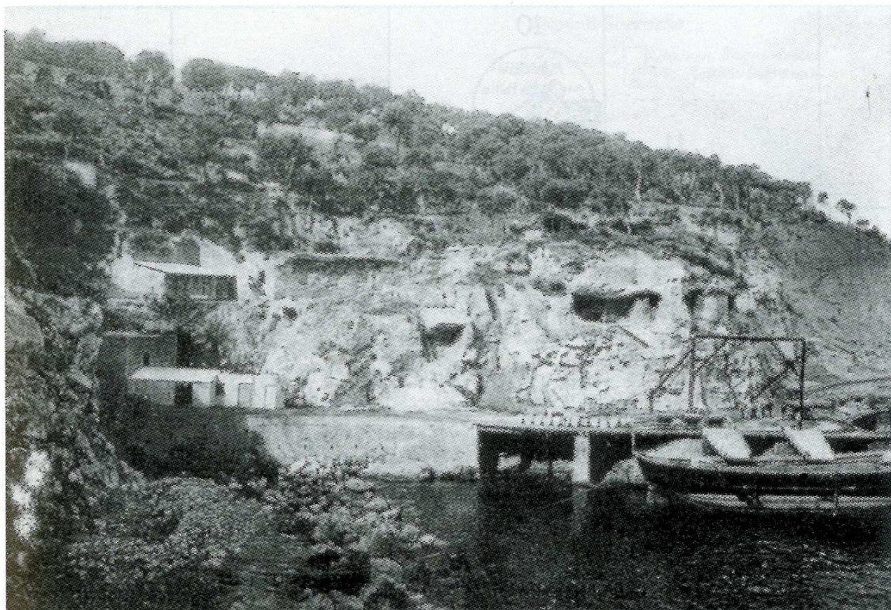
Fig. 2a. La cala di Portiglione vista da est in una foto degli inizi del Novecento. In primo piano a sinistra è visibile l'inizio dei lavori a Punta Croce. In secondo piano i ruderi della pars maritima della villa del Capo di Massa tranciati dalla strada e dai pontili di servizio alla cava Merlino. I casotti dei cantieri sono stati sistemati negli ambienti antichi.
